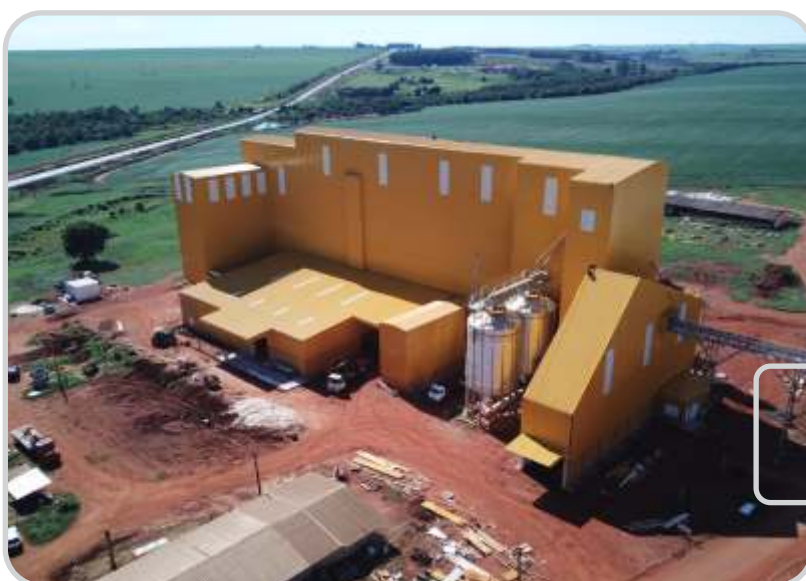
Obras da futura Fábrica Suína. São Gabriel do Oeste - MS
